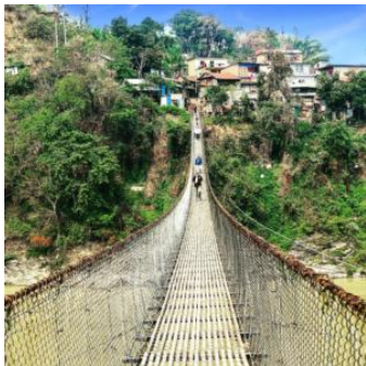
Nepal - ponte sospeso sul fiume Tirsuli
